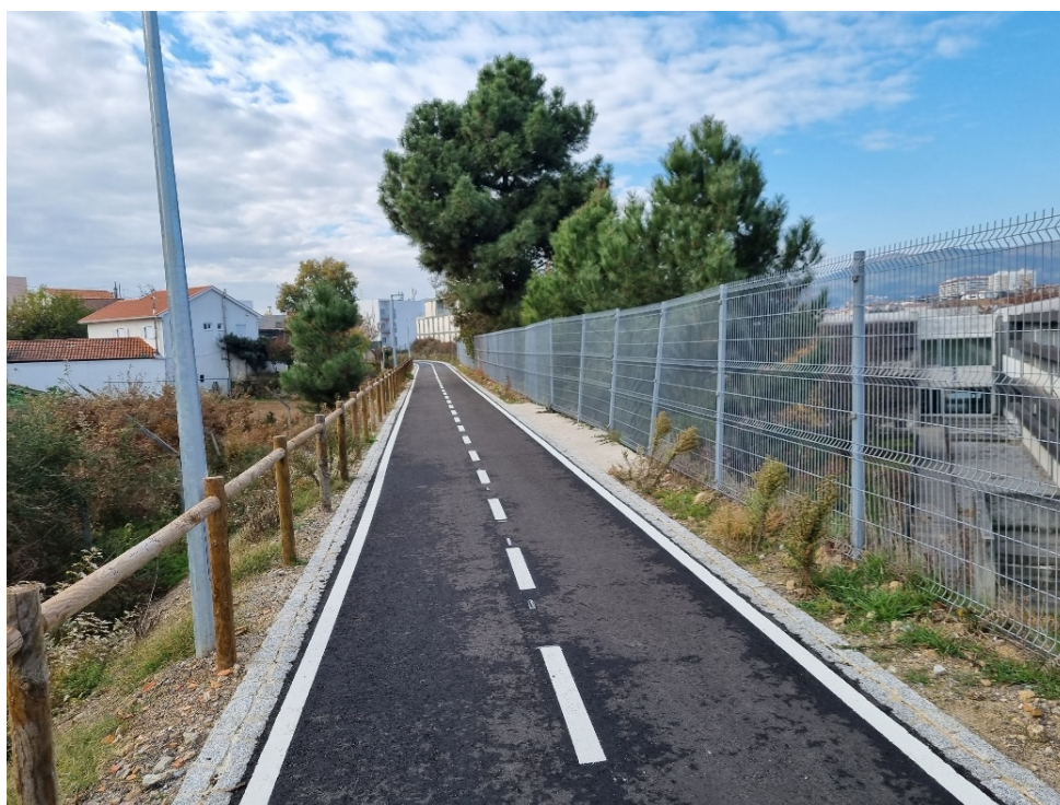
Fig. 16 Troço reabilitado da Ecopista do Corgo
