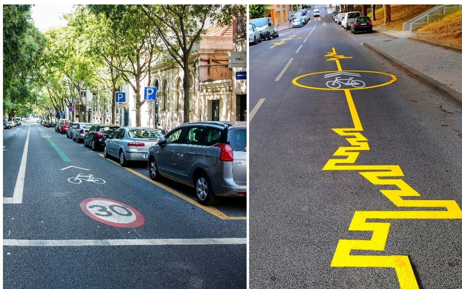
Fig. 33 Bom exemplo (à esquerda) e mau exemplo (à direita) de implementação de via ciclável partilhada
