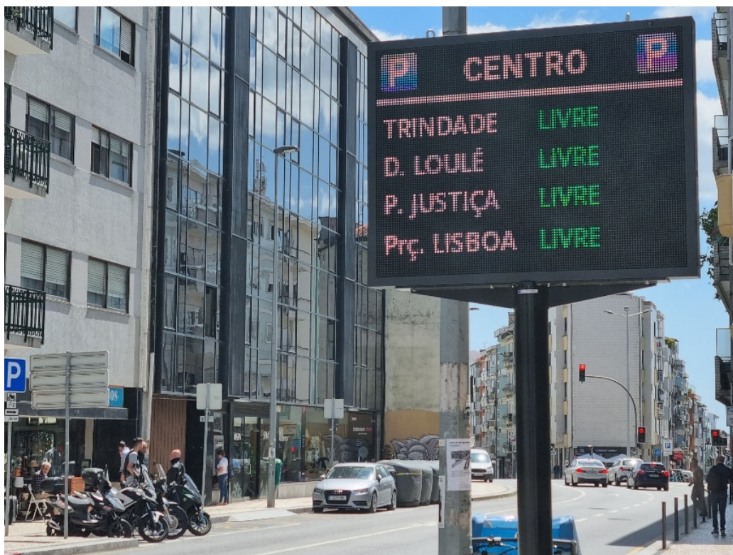
Fig. 43 Painel de mensagem variável com indicação da disponibilidade de estacionamento na cidade do Porto
