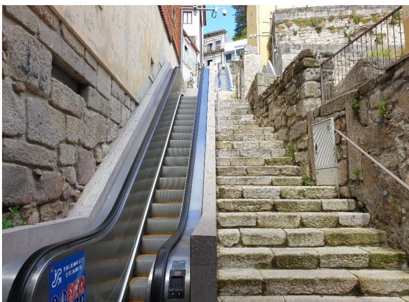
Fig. 13 Exemplo de escadas rolantes urbanas no Porto
