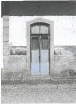
10 Portas acesso estação (em madeira, a recuperar)
