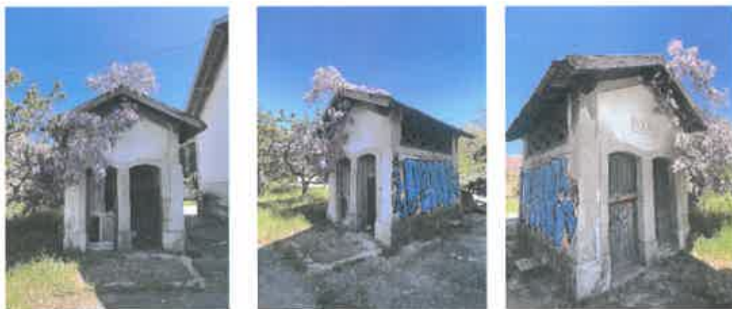
07, 08 e 09 Edifício wc exterior
